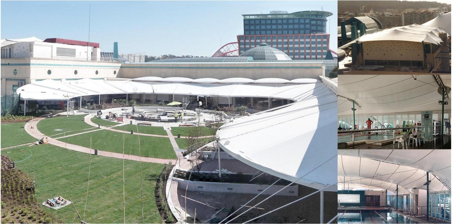
La cubierta del Centro Comercial Colombo, con una superficie de 3.100,00 m<sup>2</sup>, se construyó sobre una piscina existente. La condición principal requerida para el proyecto consistía en que la estructura fuese susceptible de ser desmontada con facilidad.
